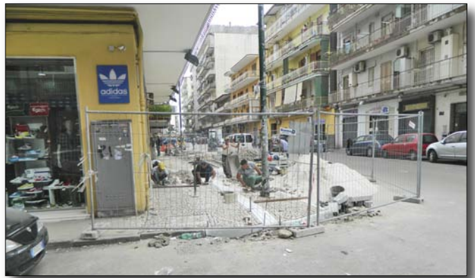
nella foto, gli operai al lavoro in via Salvador Dalì
